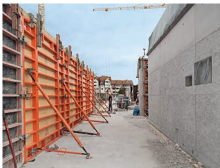
TRIO Structure est une variante du coffrage cadre éprouvé. Il peut être utilisé avec la totalité des accessoires TRIO.
