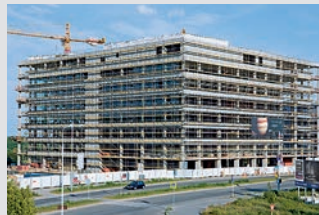
Echafaudages de façades
