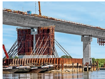
Pont sur la Vistule de Kwidzyn, Pologne
