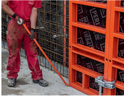
L'angle de ripage sert à la mise en place des éléments, sans l'utilisation d'un marteau.
