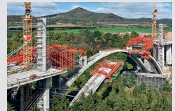
Coffrages de ponts
