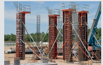
Coffrages de poteaux
