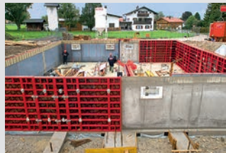
Coffrages de voiles
