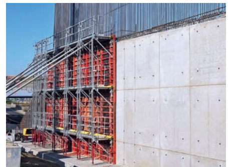
Le système TRIO peut être rehaussé jusqu'à une hauteur de 5,40 m en trame de 30 cm. Une filière de compensation est utilisée en sus pour les hauteurs plus importantes.
