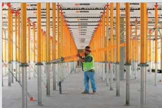
Coffrages de dalles
