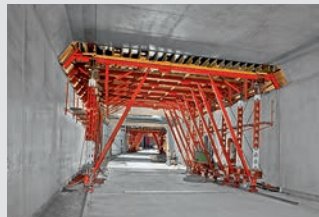
Coffrages de tunnels
